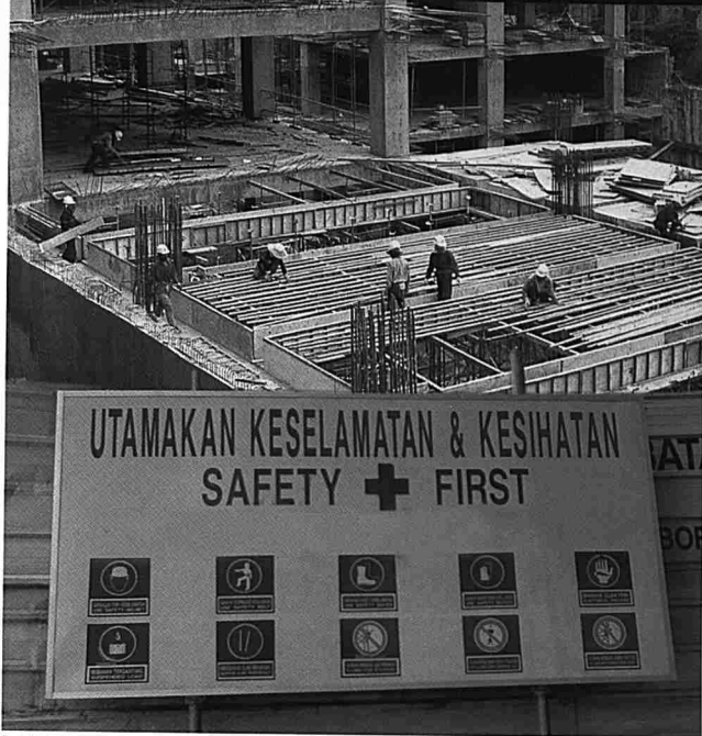
Tapak Pembinaan (Construction Site)
