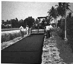
Menaikatkan Jalan Kampung (Rural Road Upgrading)
